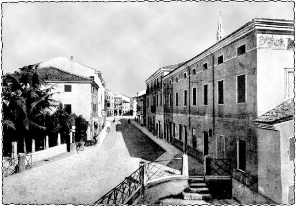
Accesso al «Lavandaro» sul ponte del Poina in via XX Settembre
